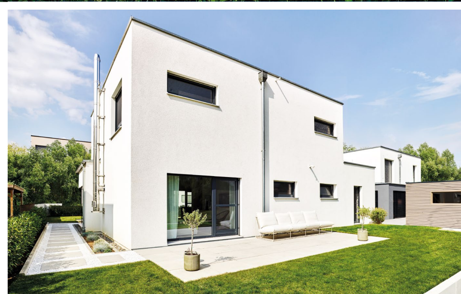
Eher zugeknöpft präsentiert sich die Gartenseite. Ganz rechts der Nebeneingang zum Technikraum mit Zugang zu Garage und Diele.
